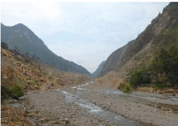
圖24 由青竹江下游往上游眺望石板溝堰塞壩體，此天然壩體已經開炸引流洩洪。
