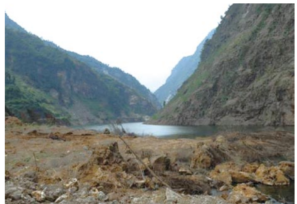
圖26 石板溝堰塞湖向青竹江上游遠眺，堰塞壩體已炸開洩流，較不具危險性。
