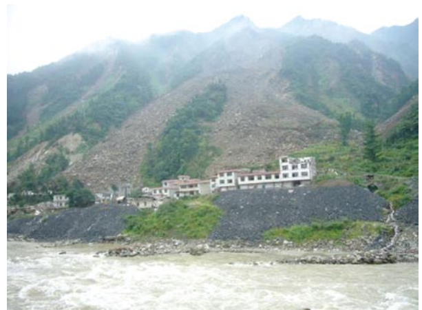
圖17 岷江左岸河岸邊的棄碴，疑似都汶高速公路龍溪隧道開挖之棄碴（疑是煤礦渣）。
