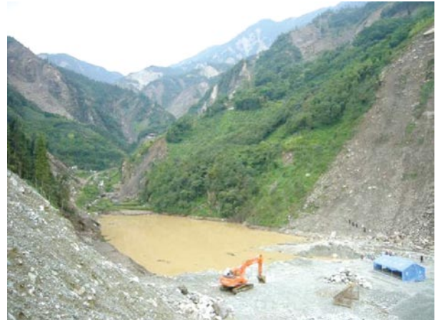
圖15 牛圈溝因支流土石碎層阻斷主流形成堰塞湖，是映秀目前水源地所在，水質混濁，將造成衛生條件的隱憂。
