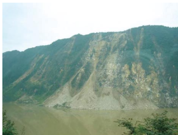
圖9 原採石殘坡因地震造成崩塌擴大，凹穀內及坡趾仍堆積不少崩積土石。
