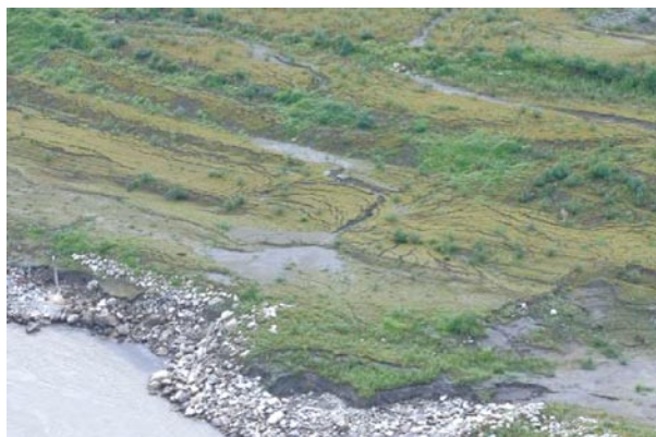
圖11 紫坪鋪水庫放空後，上游庫底岷江河岸灘地泥砂部分發生液化側潰現象，重新長滿植被。
