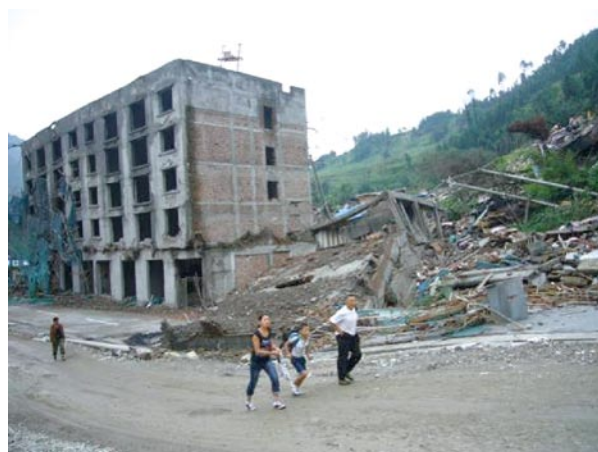
圖19 斷層經過處，人所站之處正好是逆衝所造成之爬坡位置，倒塌的建築物是映秀煙草公司，斷層上盤房屋倒塌，樹木傾斜。
