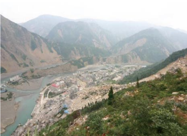
圖10 景家山崩塌掩埋坡腳之新北川中學與房舍。
