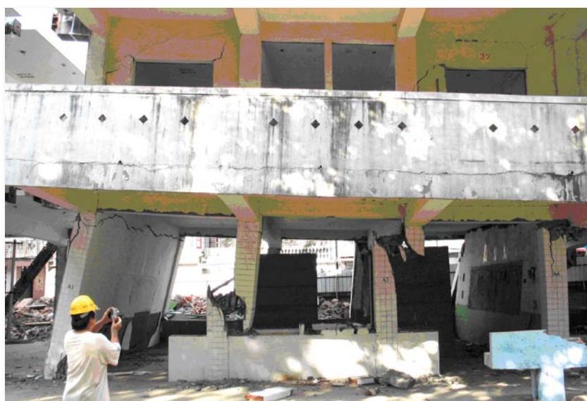
圖2 校舍現地耐震能力測試。
