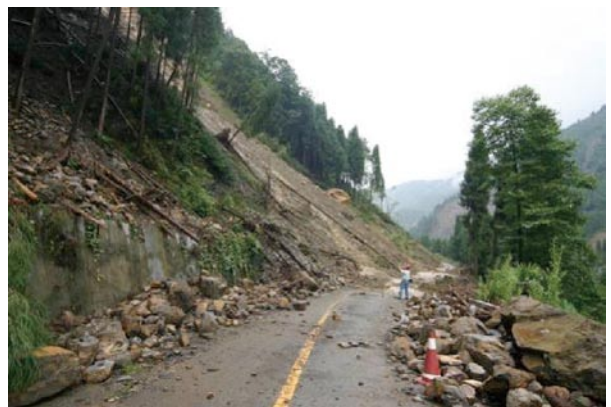
圖27 於現地調查最後一天，因前晚及當天有下雨，謝家店子堰塞湖旁公路的上邊坡持續發生滑坡及落石，造成道路中斷而無法繼續向前，為本次汶川地震現地調查的最後一站。
