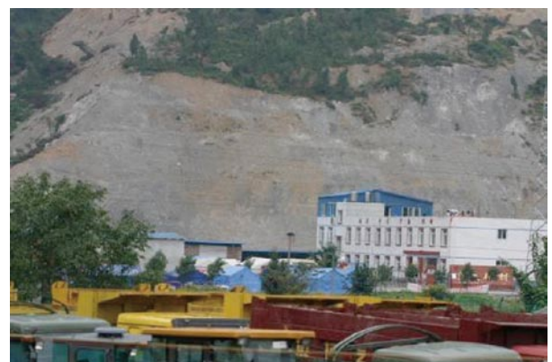
圖5 地滑將危及坡趾處許多房舍與公共設施之安全。
