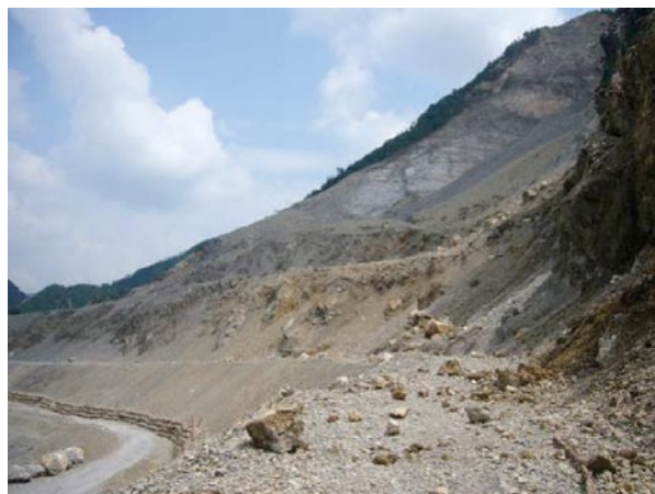
圖16 茶坪河右岸肖家橋崩塌之崩崖，為一順向坡崩塌；照片中之平臺階段，為洩流後人工整平之平臺階段，預防坡面繼續崩滑。
