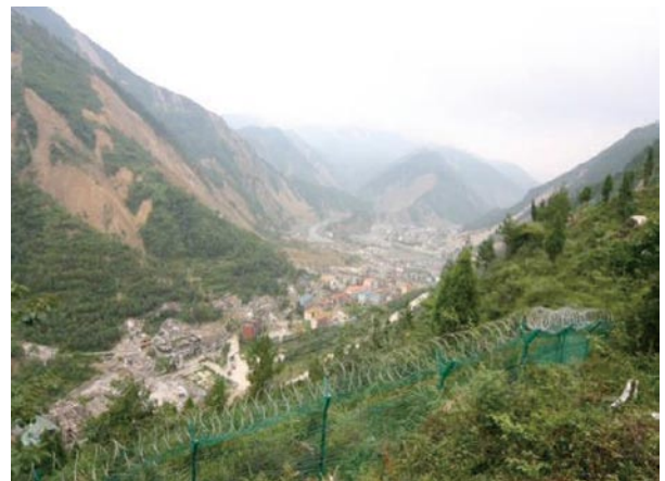
圖7 北川縣城地震後環山崩塌情形，照片下緣綠色鐵網圍籬已將縣城區全部封鎖，禁止一般人進入，並不進行復建，以保留地震災後原貌做為地震遺址博物館。
