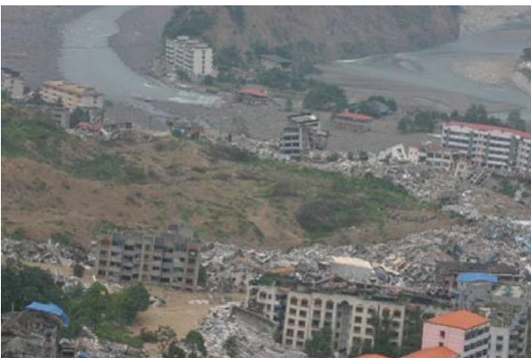
圖9 王家岩地滑掩埋舊北川縣城約1600人，以及湑江曲山段經唐家山堰塞湖洩流後淤積掩埋河岸房舍情形。
