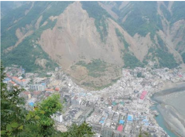
圖8 王家岩地滑掩埋舊北川縣城。王家岩地滑區地質為板岩、千枚岩、及變質砂岩等；本地滑原本就是一老（舊）地滑。
