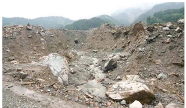
圖25 謝家店崩塌土石堆積，中央為洪水過後沖刷而成深約3公尺的渠槽。
