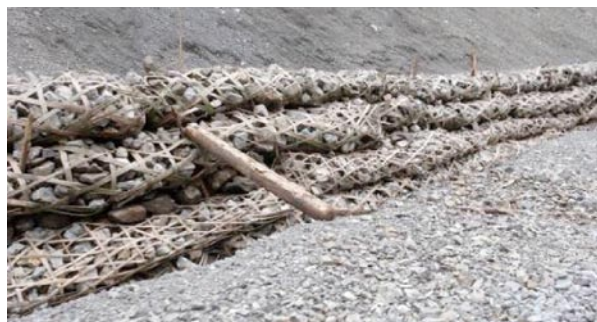
圖17 肖家橋堰塞湖開挖排洪溝，兩岸以竹編之蛇籠穩定堆積土砂坡腳。
