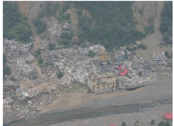
圖11 曲山鎮因地震而損毀之房屋因土石流再次受災掩埋。
