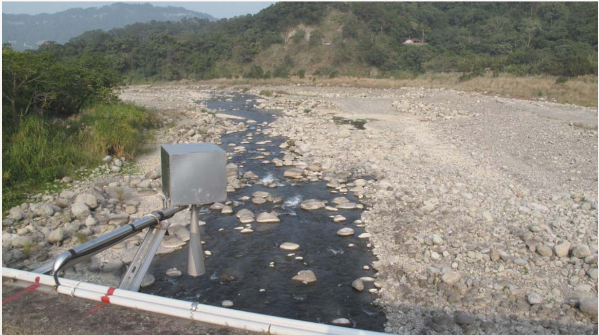
圖3 中港溪永興橋水位測站。
