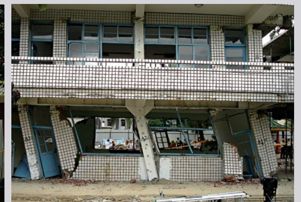
台南關廟國小架構式鋼鉸補強現地實驗。
