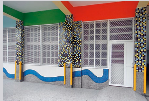
經過國震中心補強作業的校舍，沒有一棟在 327 南投地震中有結構毀損。
