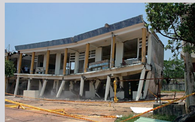
雲林口湖國小翼牆補強現地實驗。
