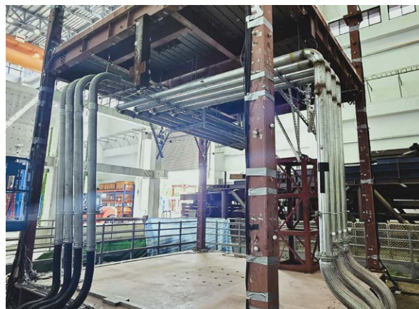
▲ 1 樓懸吊式共同管線試體
